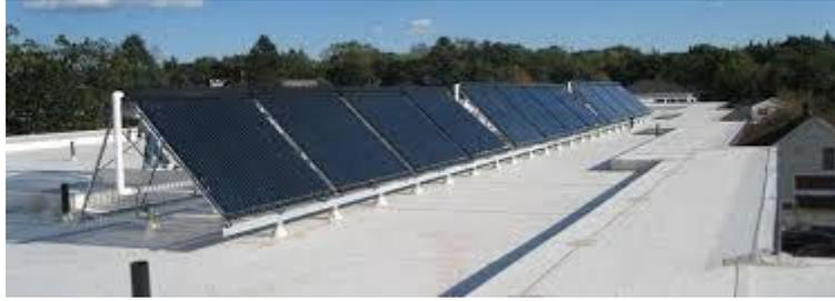
Imagen tipo de una instalación de colectores solares para la producción de agua caliente.
